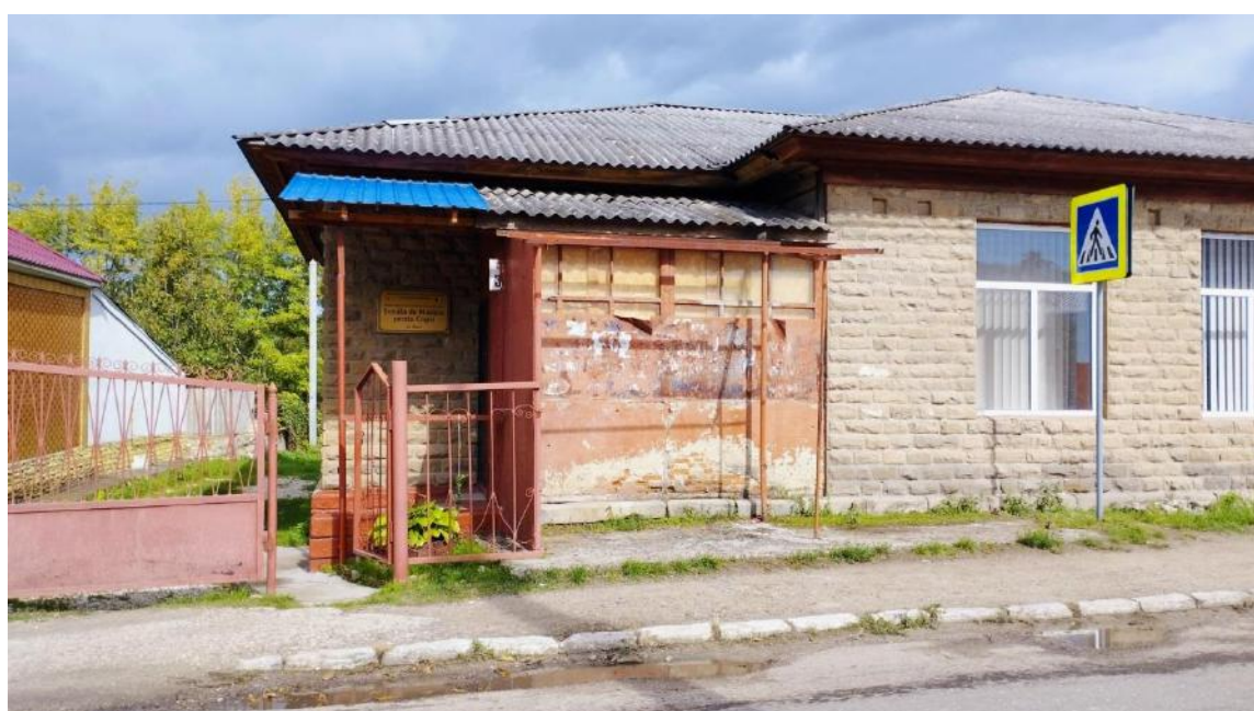
Stația transportului public
